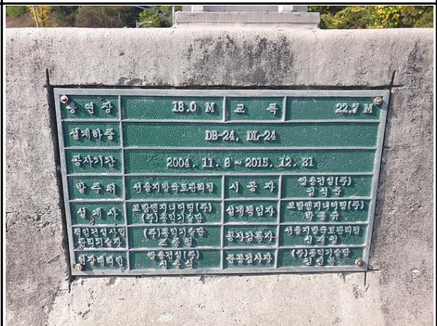
교량 상세관 전경
